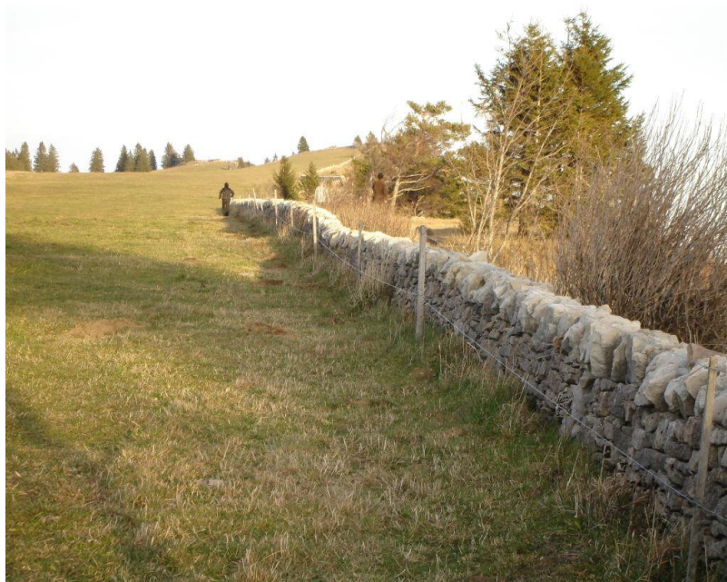
Trockenmauer am Romontberg
